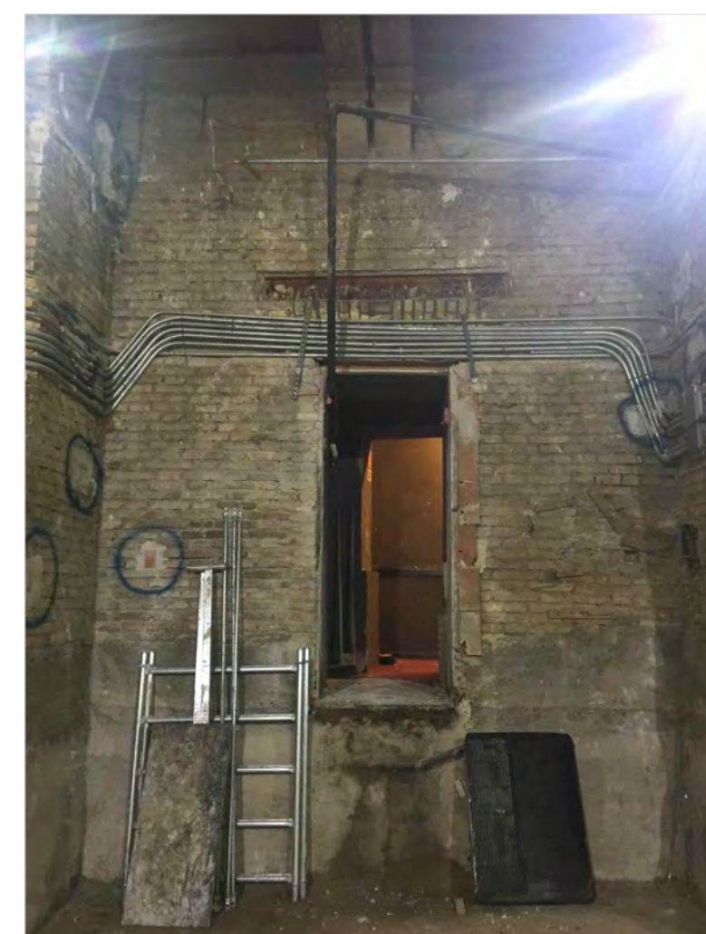
parete laterale destra in prossimità palco vano di collegamento palco/zone servizio
