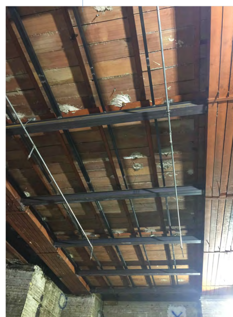
ordini di travi minori a rafforzamento ulteriore dei solai in corrispondenza della zona palco del teatro soprastante
