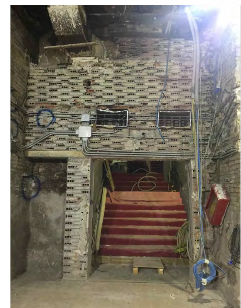
scala laterale di collegamento al foyer e ai locali di servizio laterali nonché via di esodo di sicurezza verso l'esterno
